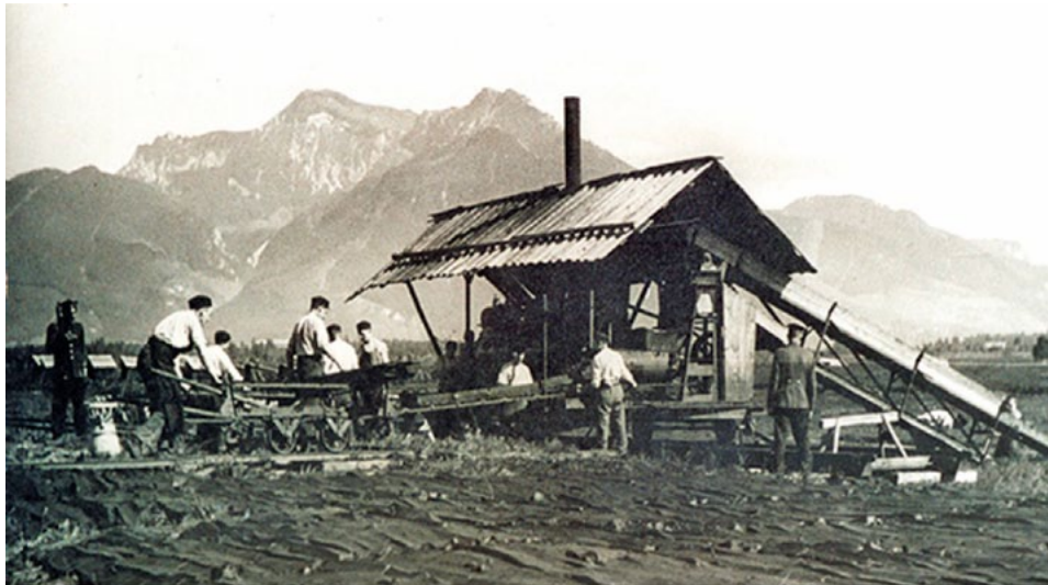
Die Torfpresen, auch „Wurstmaschinen“ genannt, wurden von Dampfmaschinen angetrieben. In den Kendlmühlfilzen waren bis zu sieben solcher Torfpresen im Einsatz.
