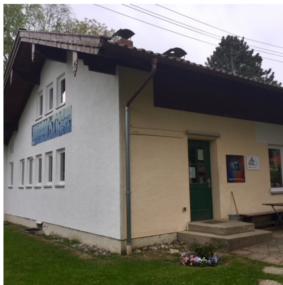
Süd-/Westseite mit Haupteingang Jugendtreff (Notausg. Norden)
