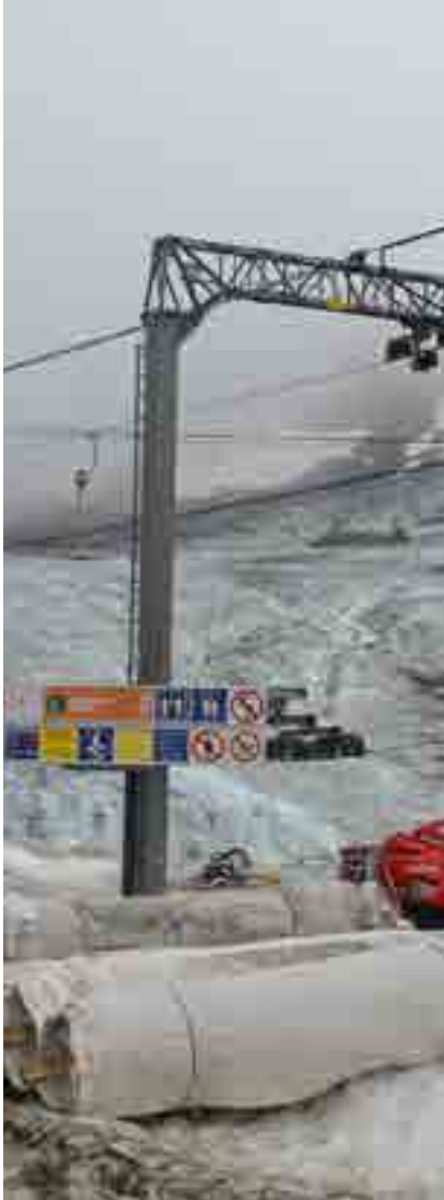
Folien zur Gletscherabdeckung an der Station Eisgrat (Stubaital, Österreich). Quelle: Alpines Museum des Deutschen Alpenvereins (DAV)
