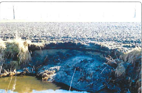
Durch Biber verursachter Uferabbruch
