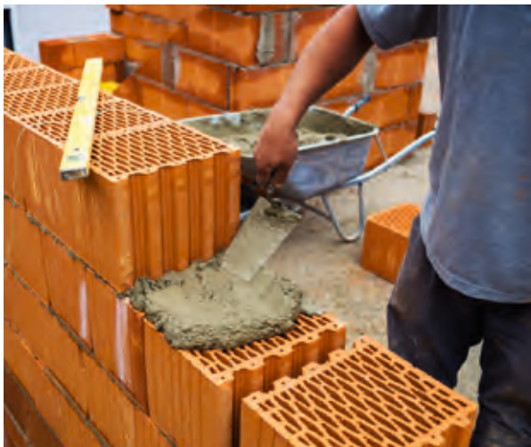
Mauerwerk aus Hochlochziegeln mit geringer Rohdichte
