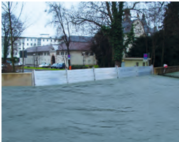
Mobiler Hochwasserschutz mit Dammbalken
