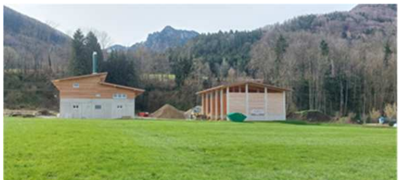
Neubau Rottau Ansicht von der B 305
