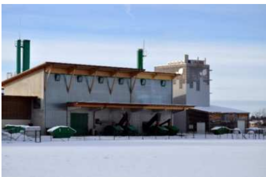
Außenansicht Heizwerk Grassau. Blick von der Staatsstraße
